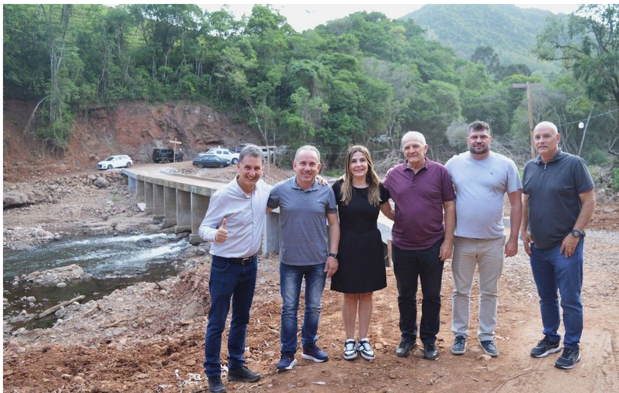
Unidos por Bento, em parceria com a prefeitura de Pinto Bandeira, restabeleceu a conexão entre Bento Gonçalves e Pinto Bandeira, no Vale Buratti, com a entrega da obra da ponte que havia sido destruída
